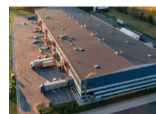
„Dommo business park“ Riga Latvia
